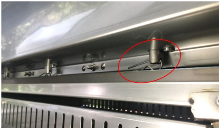
Ilustración 9 Quitar los pasadores de chaveta del quemador
